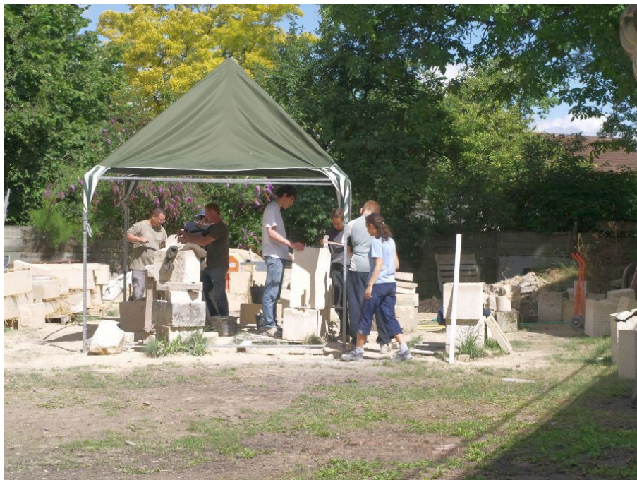
Restauratie werkzaamheden in Coucy-le- Chateau Auffrique.
